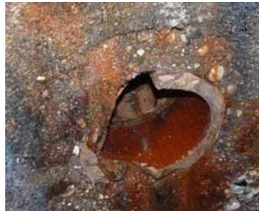
Korrosion der Schachtwandung
